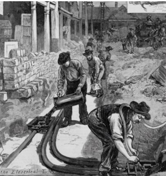
Installation des câbles électriques dans les rues de New York dans les années 1880
